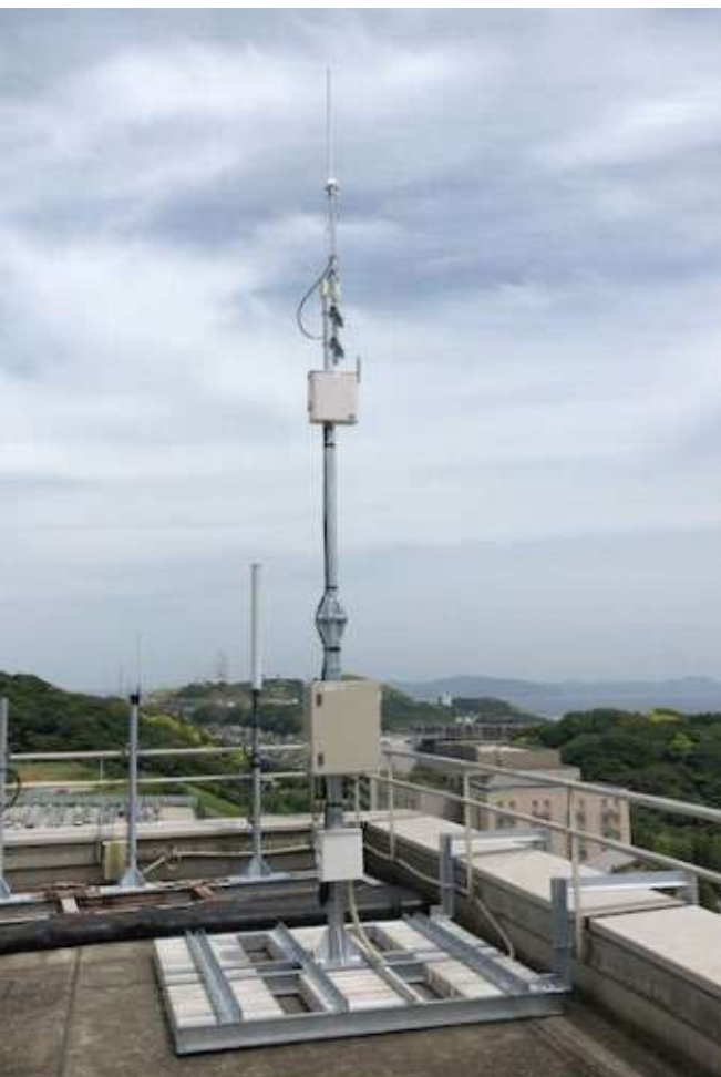
YRPセンター屋上
