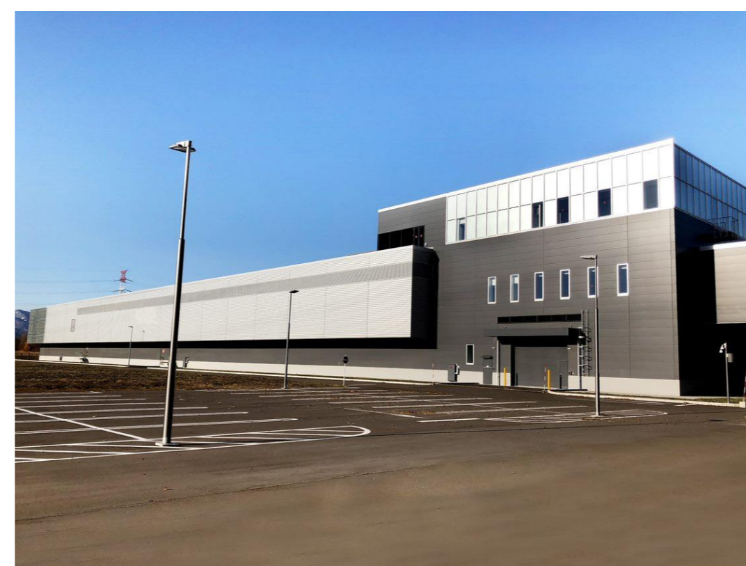
石狩データセンター3号棟
