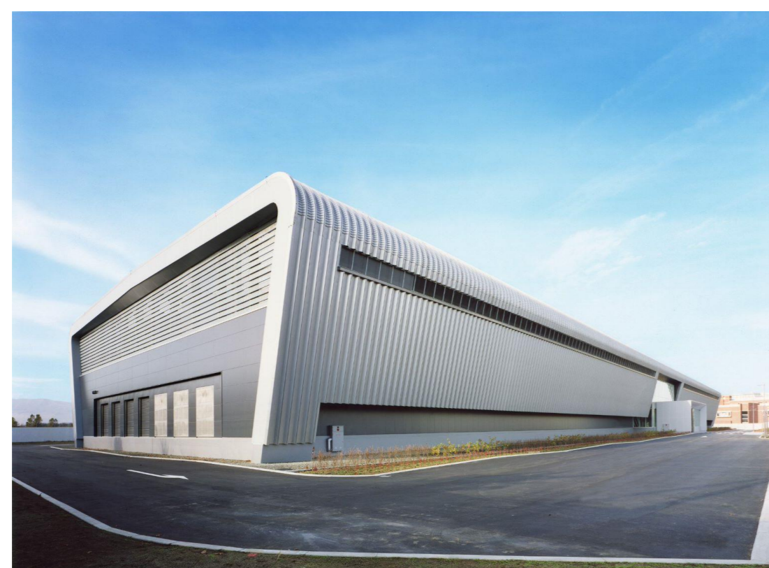
石狩データセンター1・2号棟
