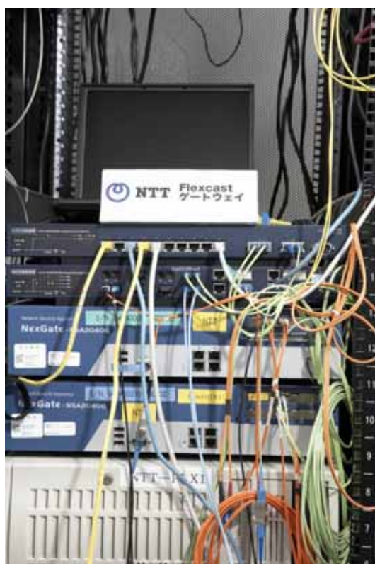
慶應義塾大学設置 N T T 製マルチ キャスト配信システム (Flexcast) 用ネ ットワーク機器
