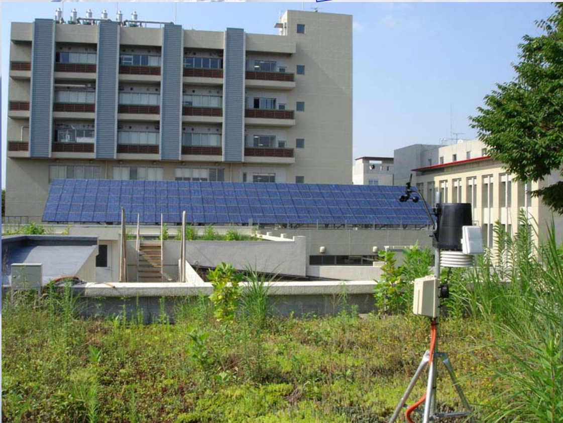
講義棟屋上緑化(12m)
